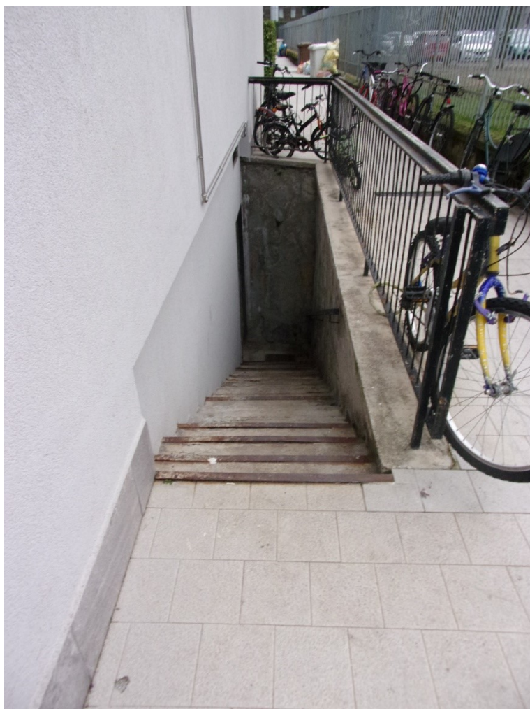
Foto 15: scala esterno per accesso piano cantine
